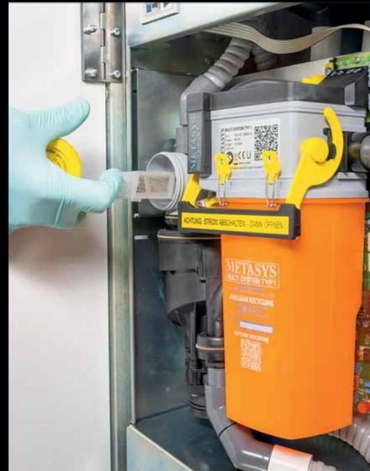
Der integrierte Metasys MST1-Amalgamabscheider ist für die Reinigung und Wartung einfach zugänglich.
